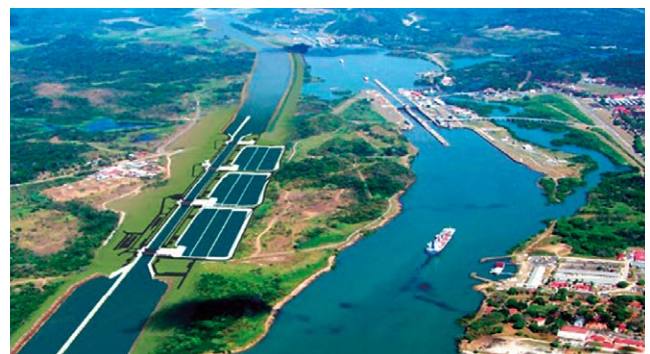
Vorne links die neue dreistufige Cocoli-Schleuse auf der Pazifikseite, rechts daneben, die bisherigen zweistufigen Miraflores-Schleusen und oben in der Bildmitte, die bisherige einstufige Pedro-Miguel-Schleuse. Auf der atlantisch-karibischen Seite werden die bisherigen dreistufigen Gatun-Schleusen mit den dreistufigen Agua-Clara-Schleusen ergänzt.
