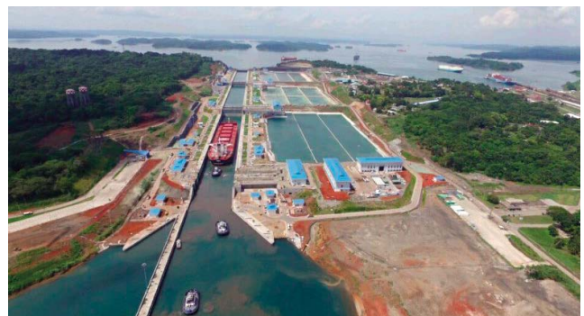
Die neue, zusätzliche Kanaleinfahrt auf der atlantisch-karibischen Seite (Agua-Clara-Schleusen) ist seit dem 26. Juni 2016 in Betrieb. Rechts im Bild ist die bisherige Zufahrt über die Gatun-Schleusen zu erkennen.
